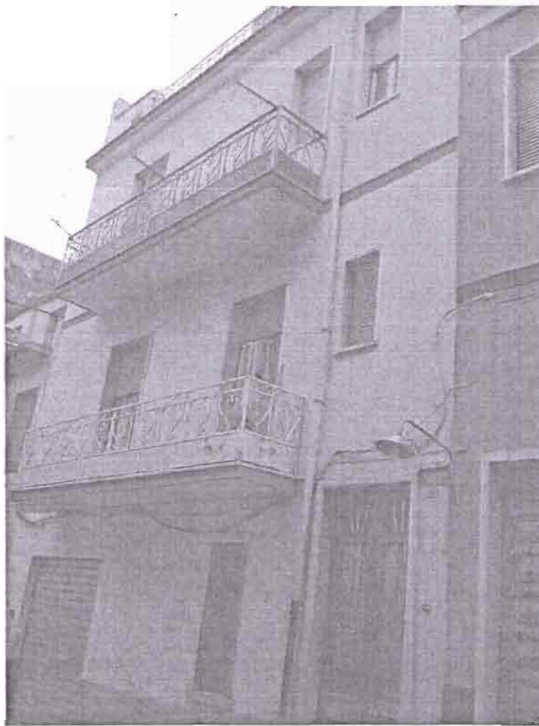
FOTO N. 1 (Via Botticelli n. 11- ex Via Napoli)
